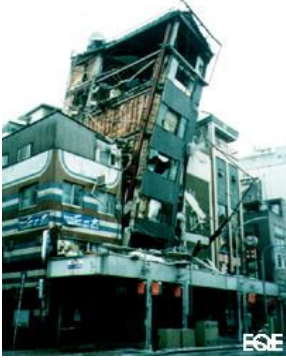
Figura 1.20 Edificio tipo lápiz afectado ( http://www.eqe.com/publications/kobe/building.htm )
