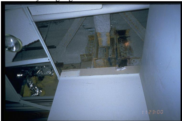
Figura 1.16 Separación de conexión entre viga y columna ( http://nisse.berkeley.edu/eqiis.html )
