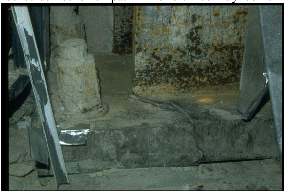
Figura 1.15 Fractura de la placa base y deformación de las anclas ( http://nisse.berkeley.edu/eqiis.html )
